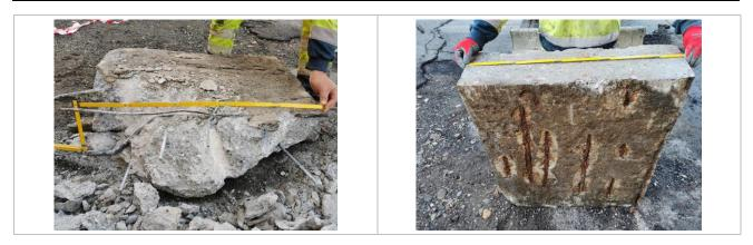
Figura 14 – schema disposizione armature riscontrato in tutte le solette ispezionate
