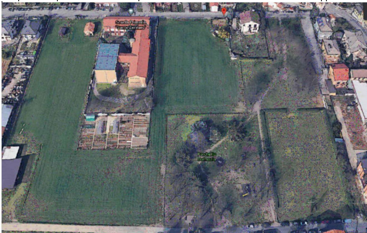
Vista dall'alto con la scuola esistente da demolire a sinistra e il sedime del nuovo intervento a destra
