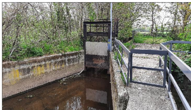
FOTO F2: VISTA DELLA PARATOIA DA MONTE
