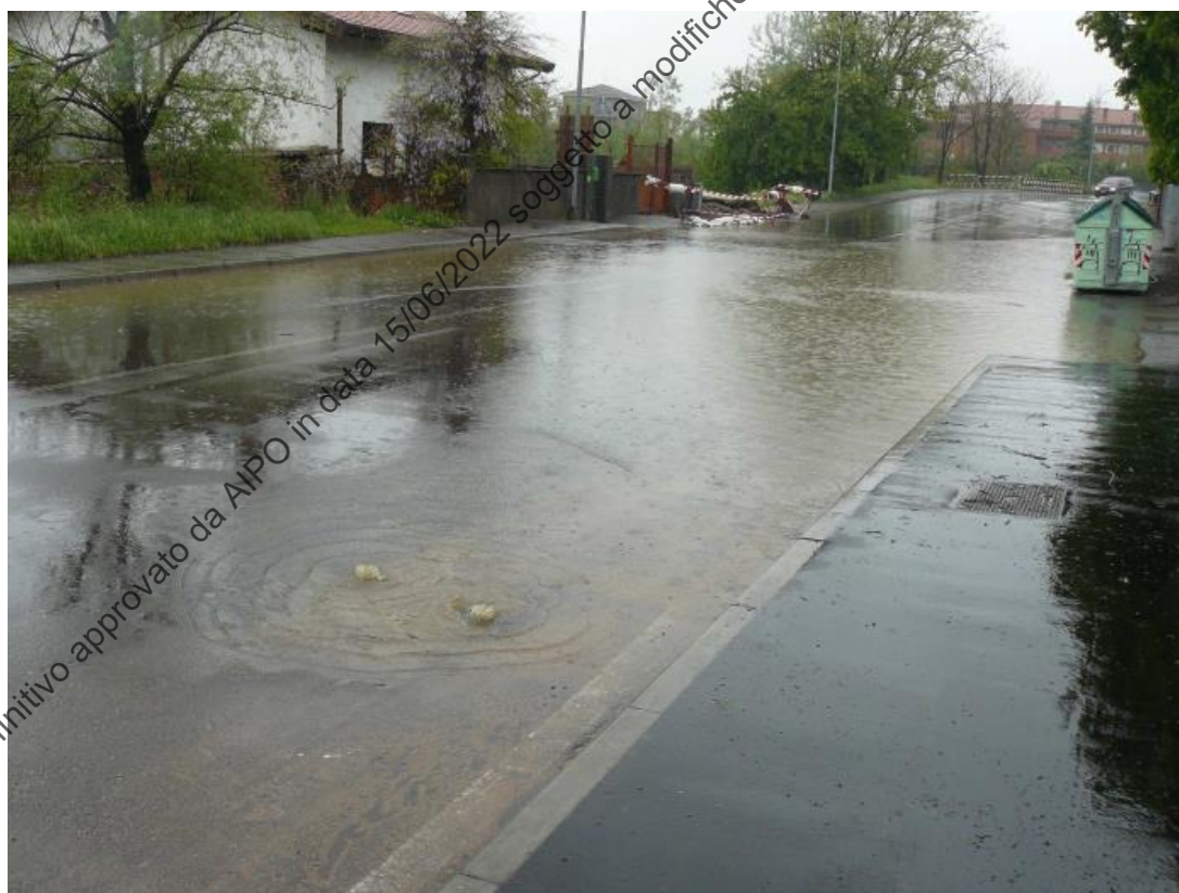
Figura 7. Allagamenti lungo via S. Martino a Rho durante l'evento del 27-04-2009 (da “Studio di fattibilità per l'adeguamento dello scolmatore sul torrente Bozzente in località Biringhello in comune di Rho”, IDRO srl, maggio 2009).
