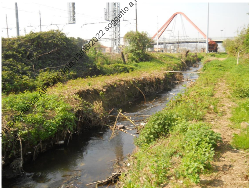
Figura 10. Materiale vegetale e rifiuti in alveo a monte della ferrovia.
