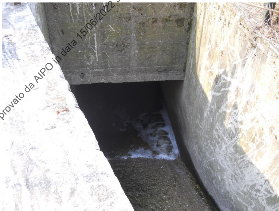
Figura 2. Imbocco del deviatore del Bozzente in località Biringhello.
