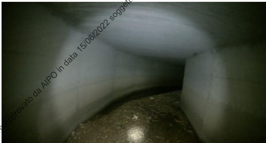
Figura 48 - interno dello scolmatore del Bozzente - buono stato di conservazione
