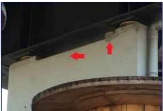
Fessura verticale e distacco su pila 10
