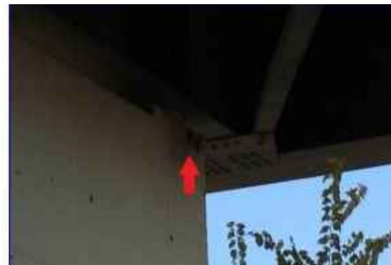
Distacco materiale su pila 9
