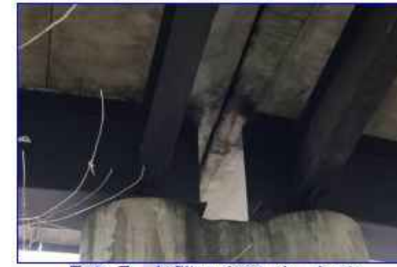
Foto 7 - Infiltrazione da giunto
