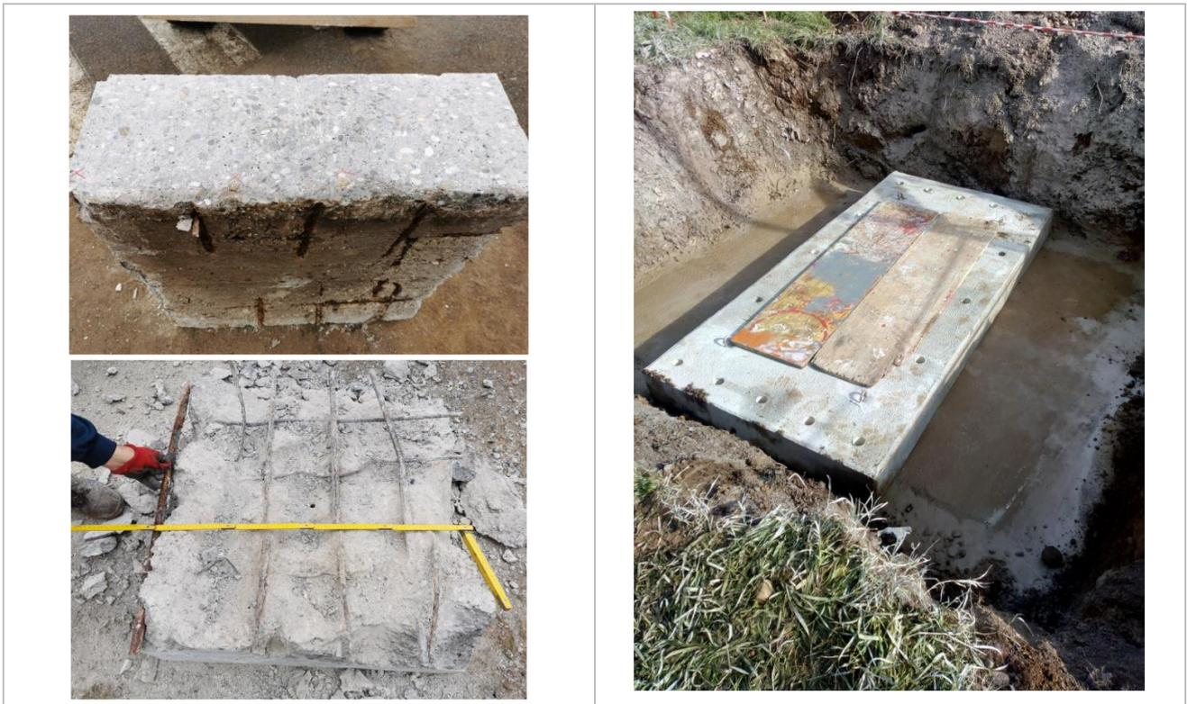
*Figura 12 – Ispezioni soletta di copertura posizione 2 (via Castellazzo)*
