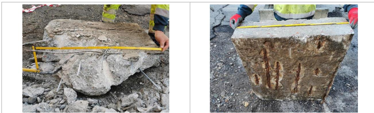
Figura 14 – schema disposizione armature riscontrato in tutte le solette ispezionate
